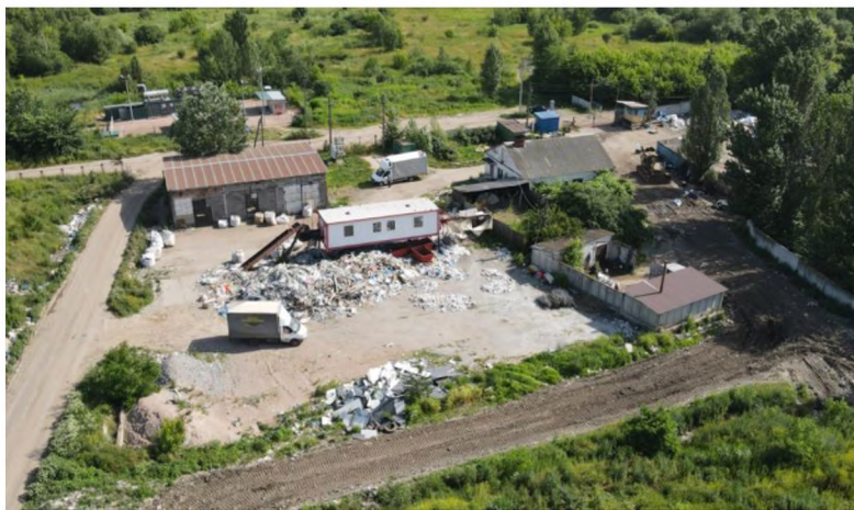
Фото 8.2.2. Роботи на полігоні ТПВ, м. Житомир
